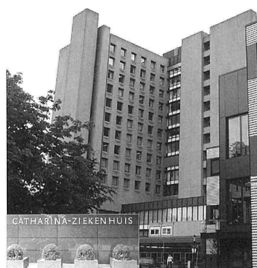
図2 カタリナ病院 アイントフェンはオランダ南部に位置し、ベルギーとの国境に程近い。
